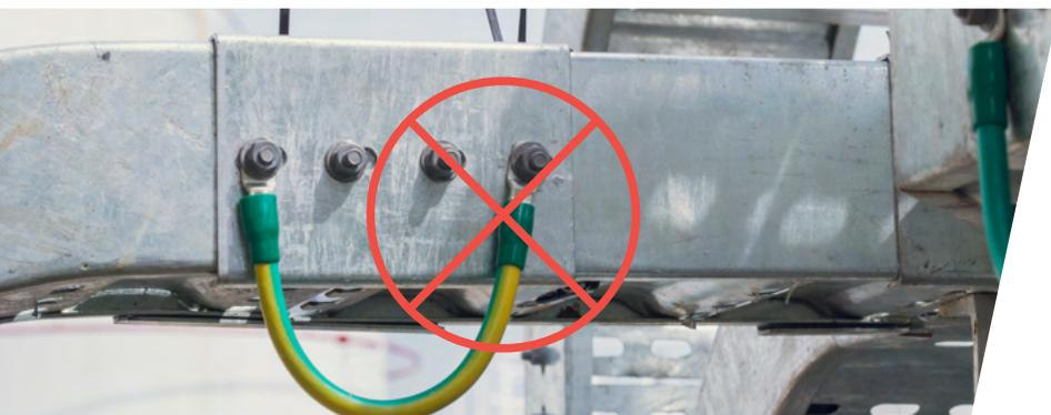
O cumprimento da norma assegura que o sistema possui continuidade elétrica, e por isso não é necessário o uso de ligações adicionais entre as peças para assegurar uma ligação equipotencial entre elas quando se instalam segundo indicações do fabricante e com os acessórios adequados.
